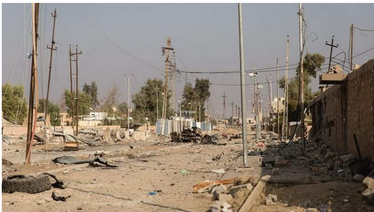
Rue de Qaraqosh après les combats de la libération (novembre-décembre 2016)
